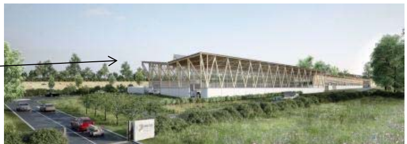
Perspective depuis l'entrée du site (bâtiment A)
